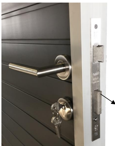
Figuur 36: detail slot tuindeur
